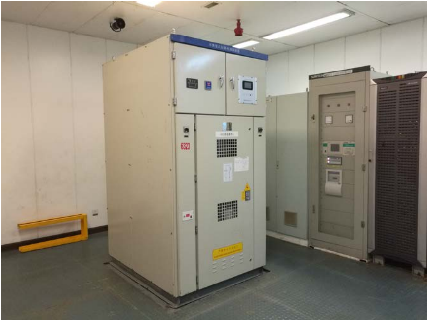
改进型的永磁断路器，采取分相控制，增加了首半波过零的预判DSP技术。可实现并不稳定的首开相第一次过零开断。
