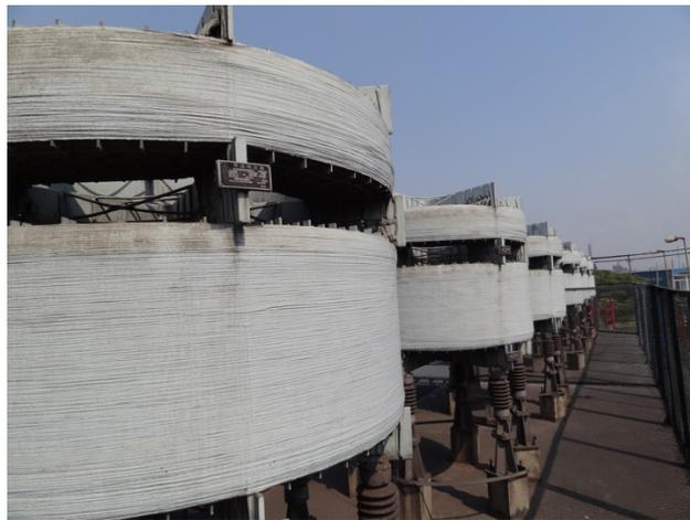
限流电抗器，是一种传统的的解决方案。由于该设备投资造价较低，简单易用，所以得以广泛使用。不论是新建还是改造项目，限流电抗器可以显著减少安装位置的短路水平。需要说明的是高阻抗变压器我们可以理解为内部装有限流电抗器的变压器，从限流的角度其都可以归为限流电抗器。
